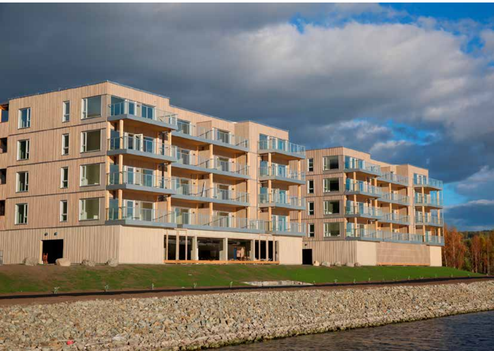
Mjøskanten Brumunddal 1. etasje Fireguard Gran B-s1,d0 innfarget.
