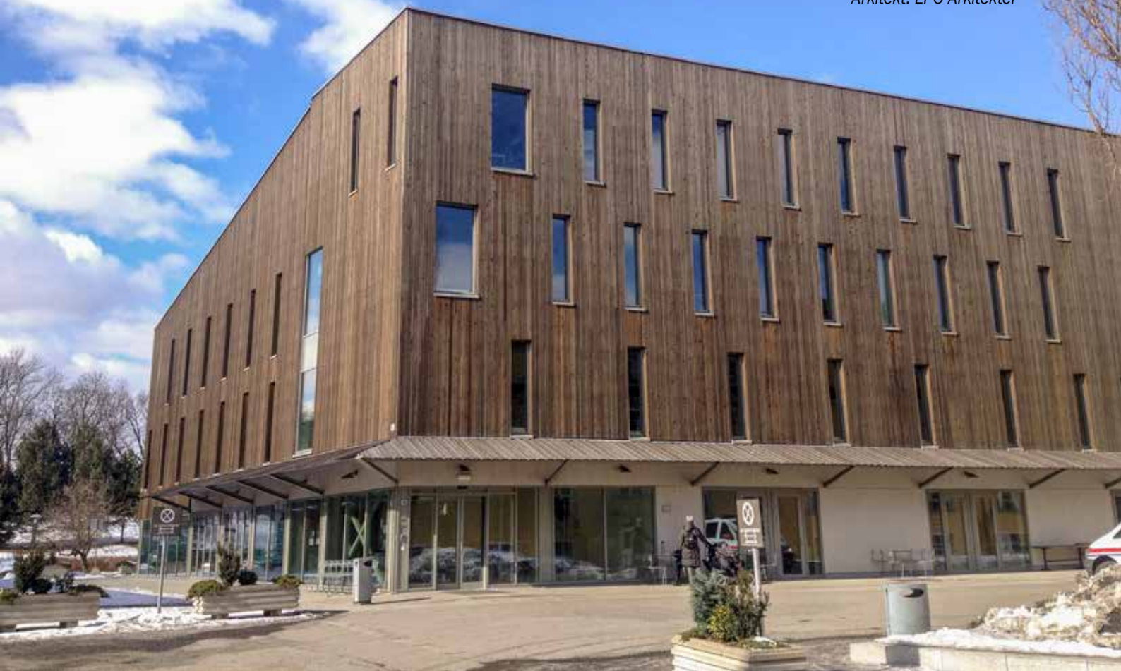
Diakonhjemmet Majorstuen. Arkitekt: LPO Arkitekter
