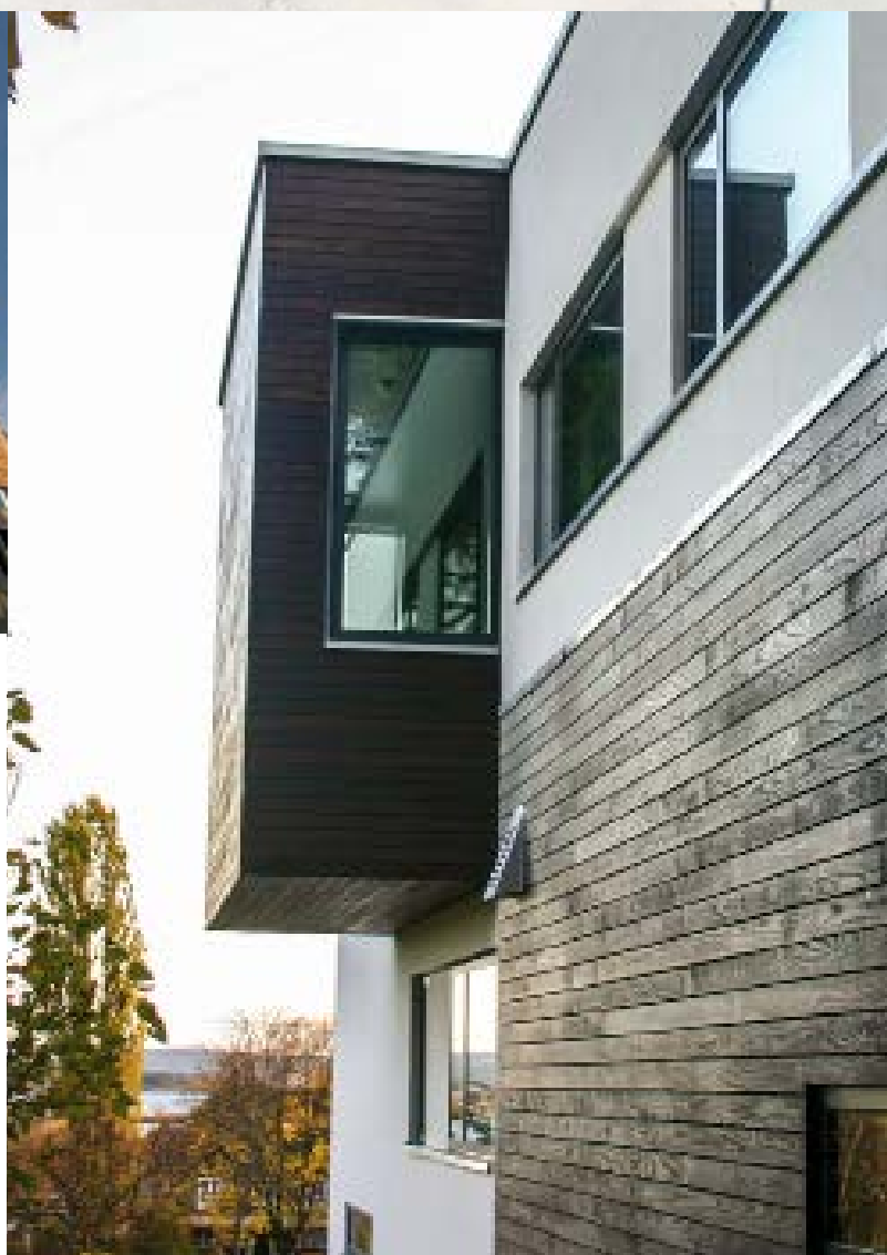
Oljet fasade termoask. Skaara Arkitekter Oslo.
