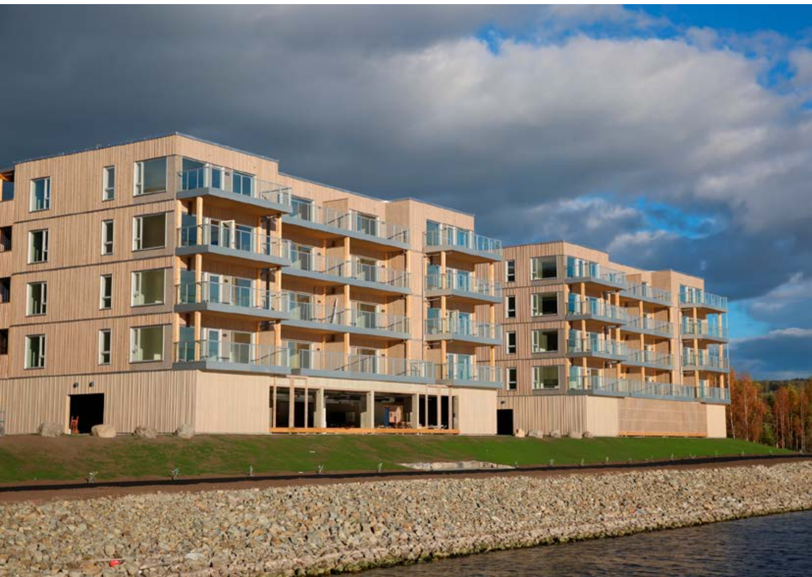
Mjøskanten Brumunddal 1. etasje Fireguard Gran B-s1,d0 innfarget.
