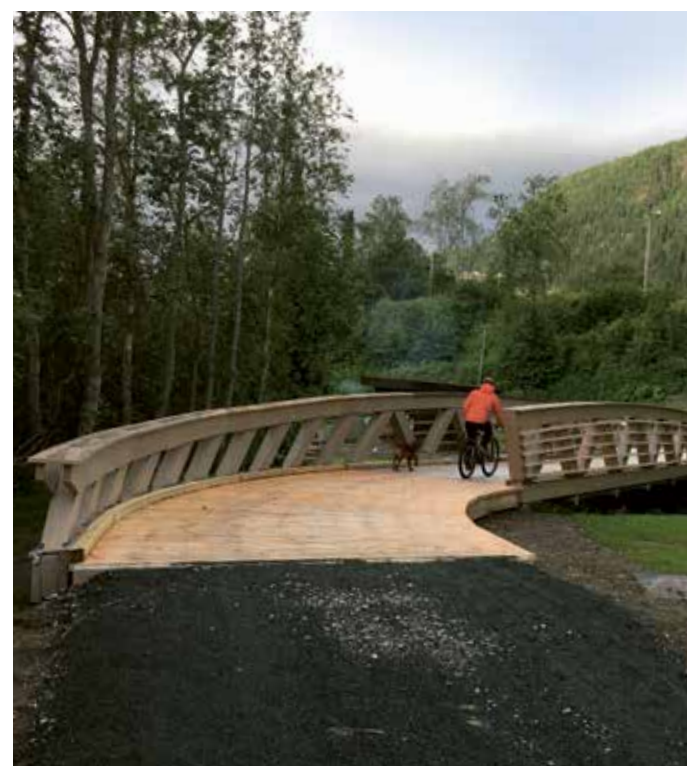
Gangbru i Orkanger
