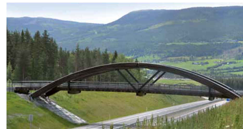
Bru over E6 ved Vinstra
