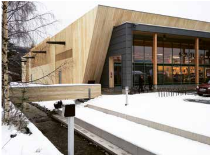
Næringsbygg på Dokka
