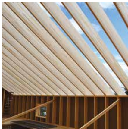
Taksperrene leveres merket, godt emballert og klare for montering. Hakk, loddkapp og garp lages helt ferdig i vår CNC-styrte bearbeidingsmaskin.
