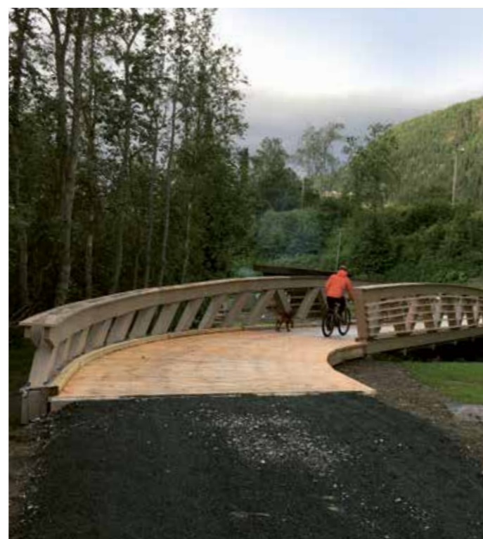
Gangbru i Orkanger
