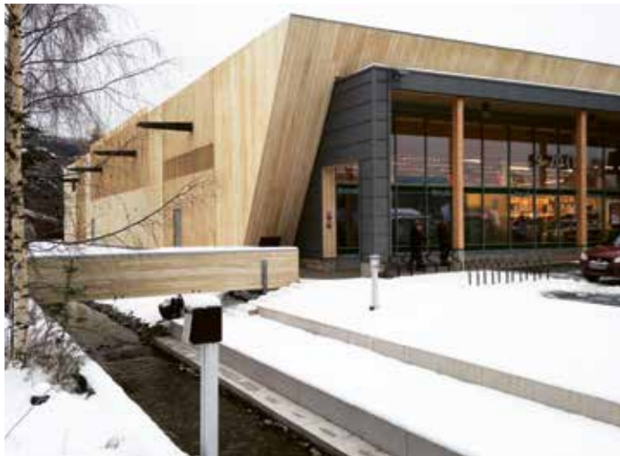
Næringsbygg på Dokka
