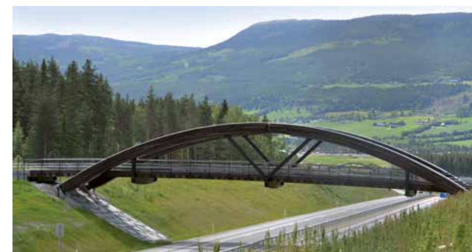
Bru over E6 ved Vinstra
