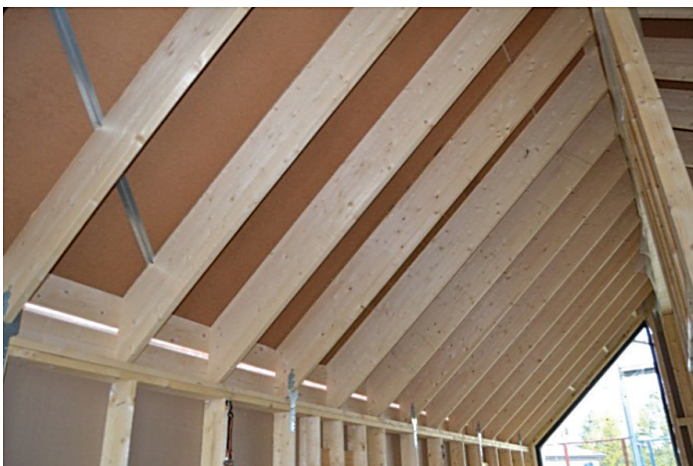
Taksperrene leveres merket, godt emballert og klare for montering. Hakk, loddkapp og garp lages helt ferdig i vår CNC-styrte bearbeidingsmaskin.
