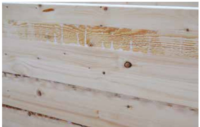
Bjelken er beregnet for skjulte konstruksjoner, da den kan ha ujevne og uhøvlede overflater som vist i bildet. Ønskes smale limtrebjelker som skal være synlige, må dette bestilles spesielt.
