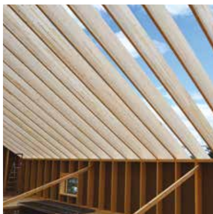
Taksperrere leveres merket, godt emballert og klare for montering. Hakk, loddkapp og garp lages helt ferdig i vår CNC-styrte bearbeidingsmaskin.
