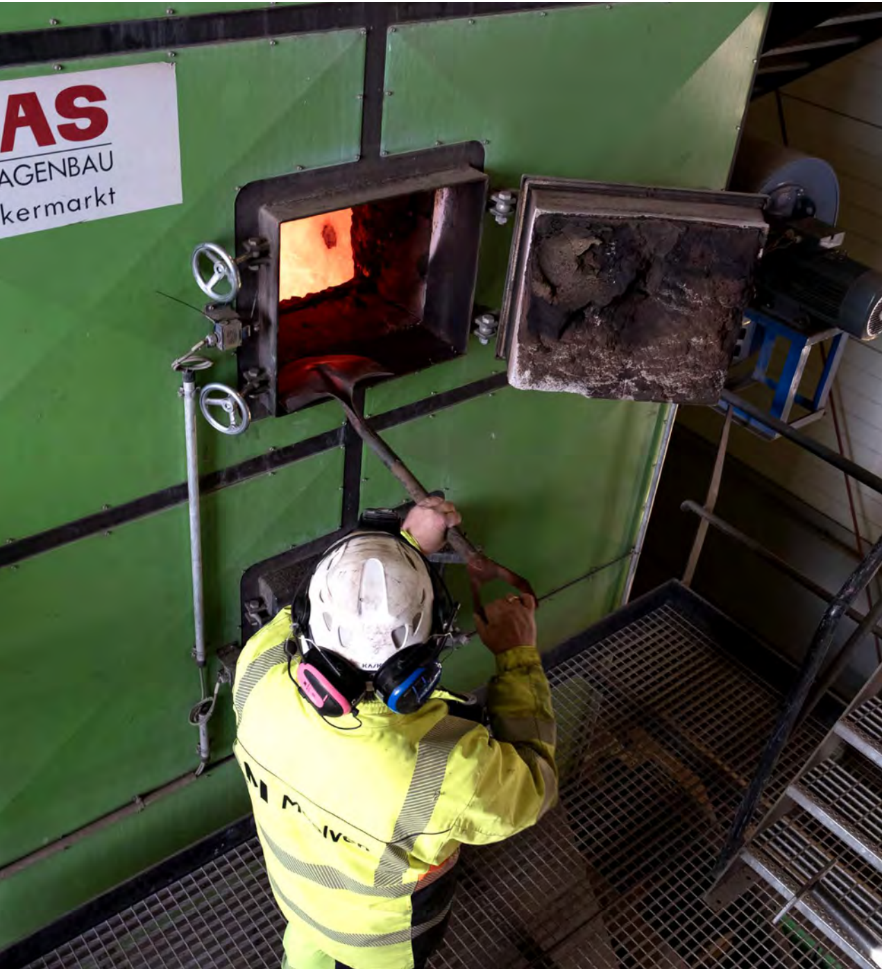
Visuell kontroll av forbreningen. Temperaturen inne i forbrenningskammeret kan komme opp mot 1000 grader C.
