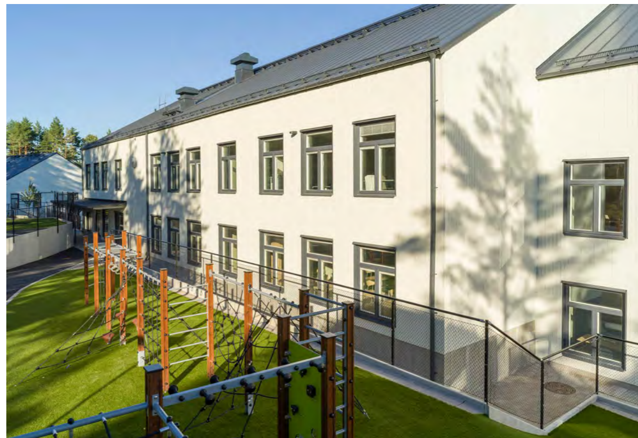
Bro Målarstrand i Upplands-Bro har fått et nytt miljøsertifisert skolebygg (Svanen) med tilhørende idrettshall, ferdigstilt på bare ett år av Moelven Byggmodul AB. Foto: Andreas Hylthén
