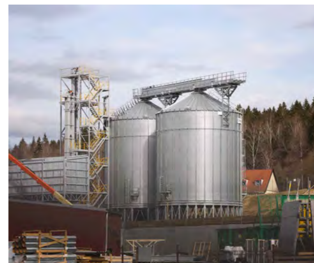
Lagersiloer for trepellets hos Moelven Pellets AB i Karlskoga. Ikke alt rest-råstoffet går til egen bioenergiproduksjon. I både Norge og Sverige har Moelven anlegg som foredrer restråstoff fra treindustrien til pellets for eksternt salg.
