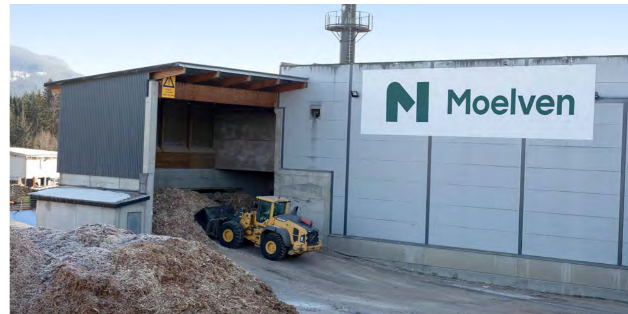
Innlasting av biomasse på Moelven Mjøsbruket AS. Biomassen består i hovedsak av barken fra sagtømmeret, iblandet andre flisfraksjoner for å oppnå ønsket fuktinnhold for forbrenningsprosessen.
