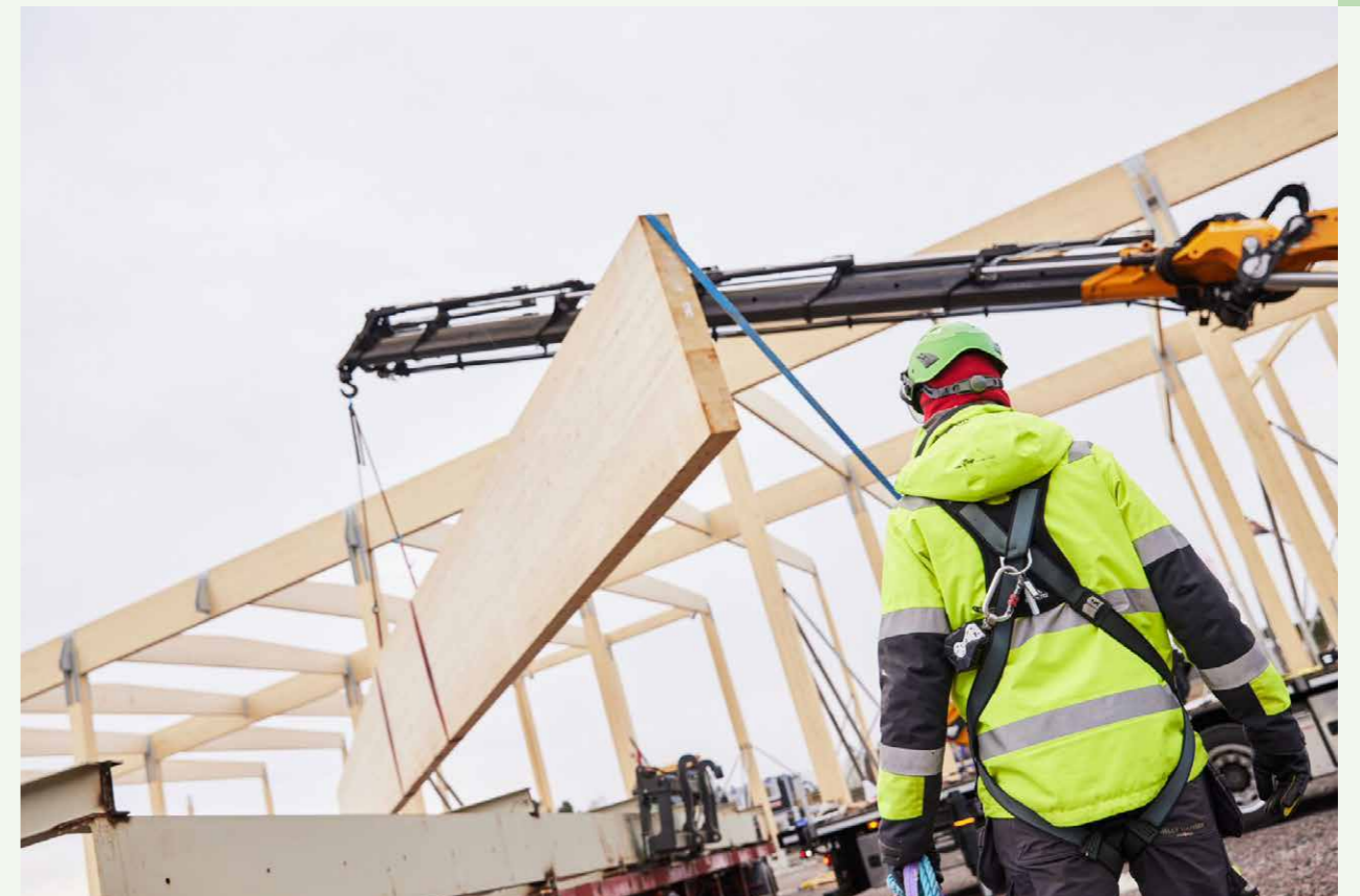
Säker och precis hantering av limträkonstruktioner under montage.
