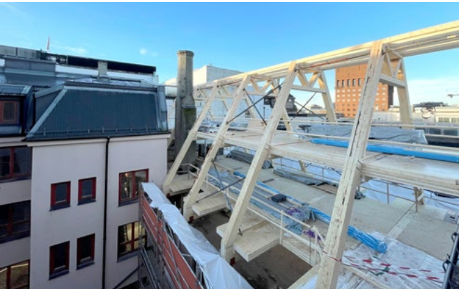
Högt upp i byggnaden på Øvre Vollgate 11 byggs två nya våningar i limträ från Moelven.
