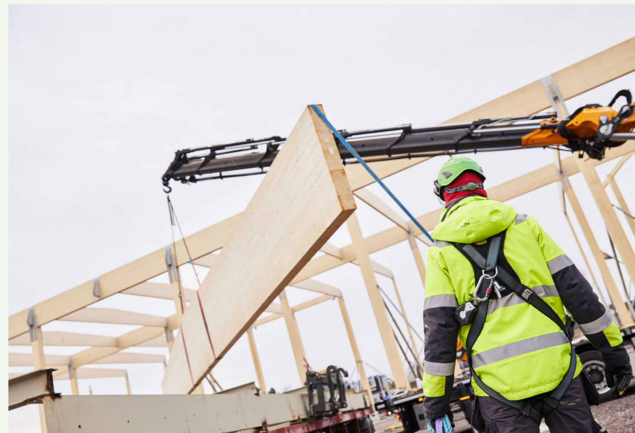
Presis og trygg håndtering av limtrekonstruksjoner under montasje.
