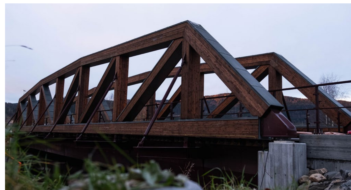
Lillehammer kommune har i 2024 bygget en helt ny fagverksbru for gående og syklist i limtre fra Moelven.
