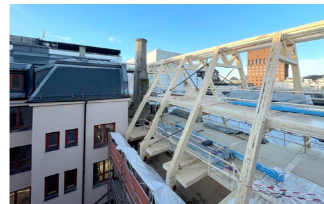
På toppen av bygningen i Øvre Vollgate 11, bygges det to nye etasjer i limtre fra Moelven.
