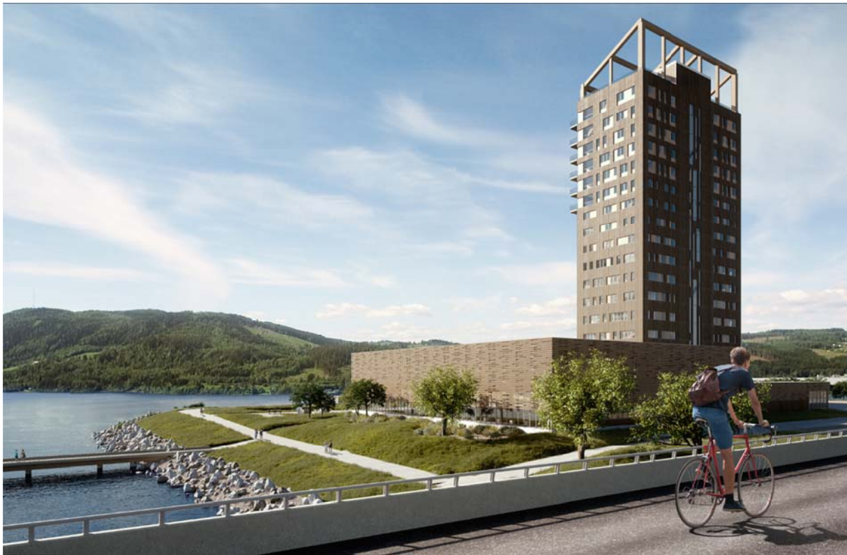
«Mjøstårnet» - Verdens høyeste trehus, prosjektert ferdigstilt i 2019. Moelven Limtre AS skal levere og montere alle trekonstruksjonene i perioden fra september 2017 til april 2018.
