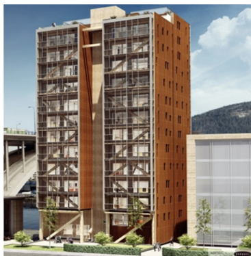
Byggingen av verdens høyeste trehus, «Treet» i Bergen, ble påbegynt i fjerde kvartal 2014. Bygget skal, når det er ferdig høsten 2015, bestå av 14 etasjer og være 51 meter høyt. Bærekonstruksjonene i limtre leveres og monteres av Moelven Limtre AS.
