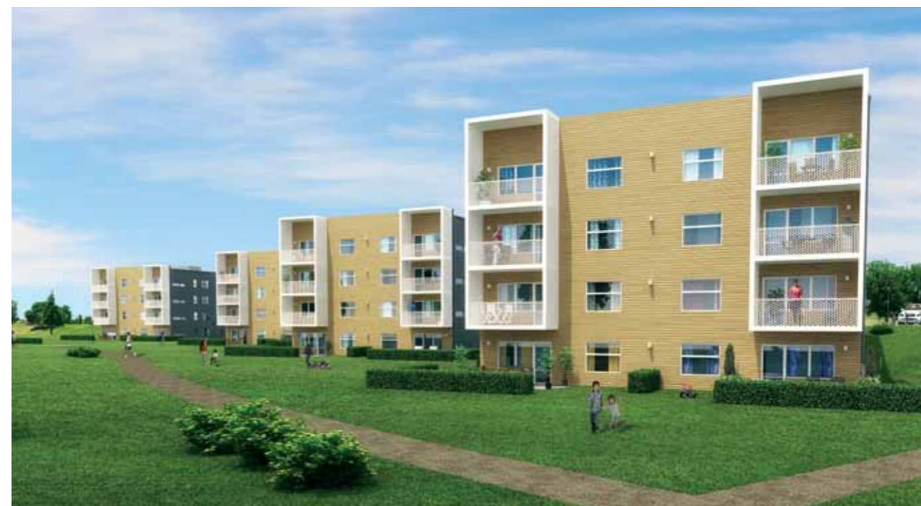
I Barkarby Hage utenfor Stockholm er det under oppføring modulbaserte 4-etasjersbolighus med 2-5-romsleiligheter, som leveres av Moelven ByggModul AB.
