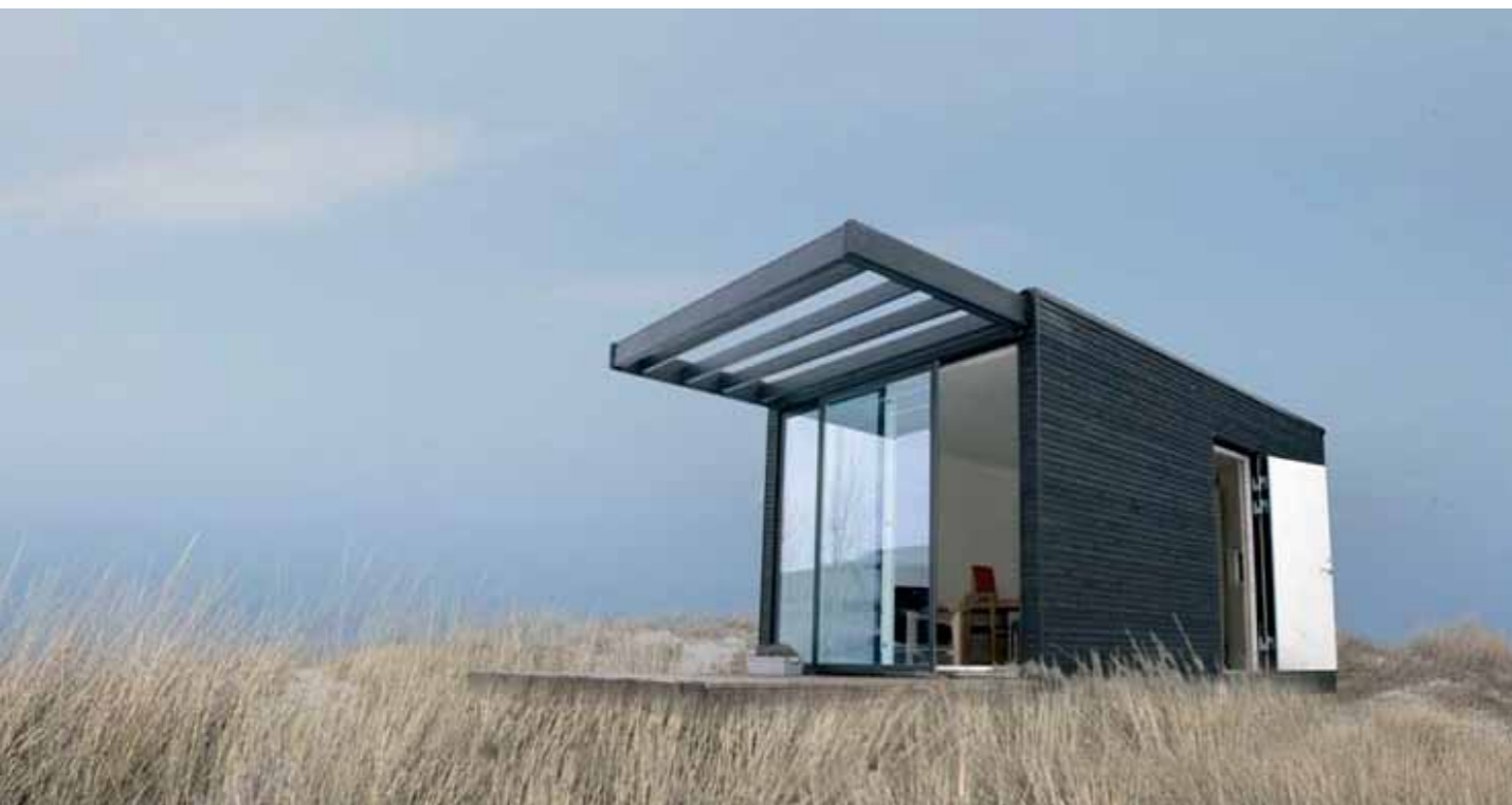
Minihuset ONE+ på 15 kvadratmeter bygges med prefabrikerte moduler av organisk impregneret svensk gran. Arkitekt: Lars Frank Nielsen, produsent: Add-A-Room, Tyresö, Sverige.
