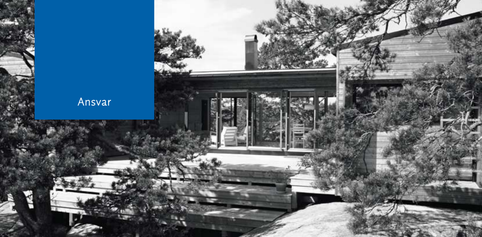
Fritidshuset ved Portør på den norske Telemarkskysten står blant furuene på berget. Det er bygd i furu inne og ute med ytterpanel i kjerneved av furu.
