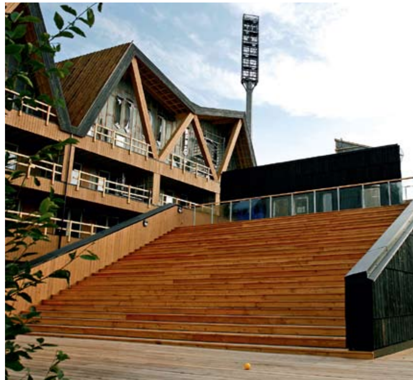
Egenes Park i Stavanger består av 56 leiligheter, et daghjem for barn og flere andre bygg, og er et av Nordens største byggeprosjekt i massivtre. Moelven MassivTre AS og Moelven Limtre AS har levert de bærende konstruksjonene samt gulv-, vegg- og takelementene.
