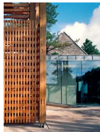
Mortensrud kirkes bærende konstruksjoner er i limtre.
