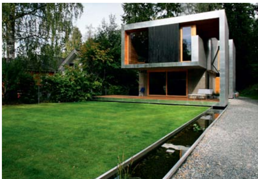
Denne villaen på Smestad utenfor Oslo har elementer i massivtre i vegger og tak, levert av Moelven MassivTre AS. Arkitekt er Knut Hjeltnes AS Sivilarkitekter MNAS.
