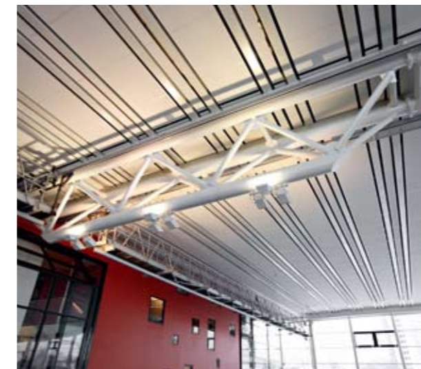
Ved 50-metersbassenget med åtte baner var kravet til god belysning spesielt stort, siden anlegget også skal brukes til konkurranser og må ha nok lys for tv-overføringer.
