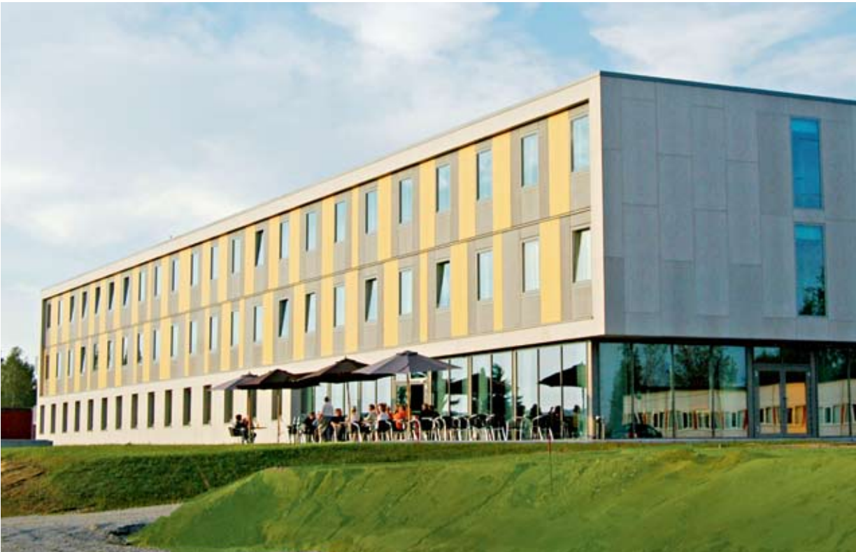
Moelven ByggModul AS har levert 119 hotellromsmoduler til Gardermoen Gjestegård. Gjestegården ligger rett ved Oslo Lufthavn Gardermoen i Norge og var klar til åpning i 2007. Hotellrommene leveres ferdige med flislagte bad, montert baderomsinnredning og varme- og ventilasjonssystem.
