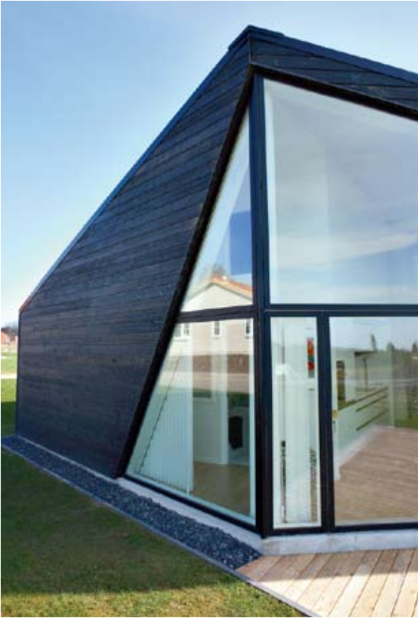
Tre fra Moelven Danmark A/S er brukt i visjonær dansk husarkitektur. Kip House er tegnet av arkitektfirmaet 3XN og produsert av byggefirmaet M2. Treet i huset er fra Finnforest ThermoWood, og er varmebehandlet, grunnet, sluttbehandlet og leveres ferdig til montering.
