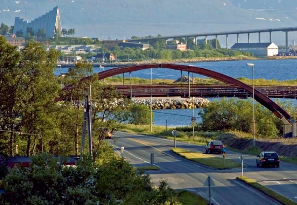
Tomasjordnesbrua i Tromsø, Troms, er en gang- og sykkelbru, bygd i limtre fra Moelven Limtre AS. Det tverrspente, 110 meter lange tredekktet holdes oppe av en buekonstruksjon over veien. Bruer i limtre er estetisk tiltalende og bestandige i aggressive miljøer.
