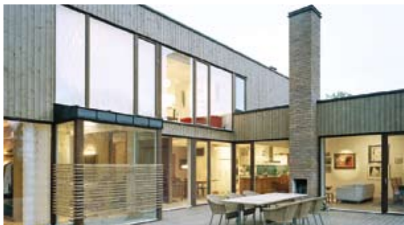
Villa Roser, eid av ekteparet Roger og Claudine Roser, er tegnet av den kjente svenske arkitekten Gert Wingårdh og er for en stor del bygd opp av massivtre fra Moelven MassivTre AS. Moelven MassivTre AS henter blant annet sitt råstoff fra svenske og norske Moelven-sagbruk.
