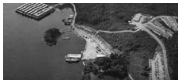
1972/76 – Bygges nye fabrikker for produksjon av komponenter for husindustrien. «Oljeeventyret» gir Moelven store leveranser til bl.a. Kårstø og Rafsnes.
