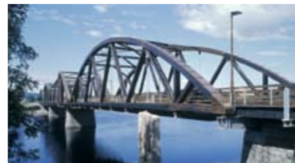
Industrierte fra Timber blir benyttet som innsatsvare i produksjon av limtre. Bildet viser limtrekonstruksjoner fra Flisa-brua over Glomma.
