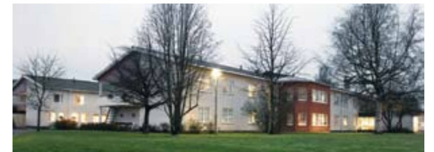
Moelven Årjäng Säg AB leverer fjernvarme til Årjäng kommune via sitt fjernvarmeanlegg på sagbruket. Kvarnåsen Aldershjem er en av institusjonene som bli varmet opp av miljøvennlig energi i form av flis og bark. Moelven har igangsatt en større satsing på bioenergi som forretningsområde.
