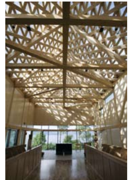
Moelven Limtre AS har levert de spektakulære limtrekonstruksjonene i Mariaklosteret i Nord-Trøndelag. Moelven Limtre AS er Norges ledende leverandør av standard limtre og avanserte limtrekonstruksjoner til byggeprosjekter.
