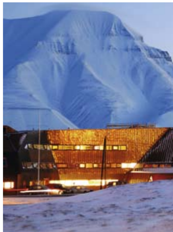
Moelven Limtre AS leverte limtrekonstruksjoner til den nye forskningsparken i Longyearbyen på Svalbard
