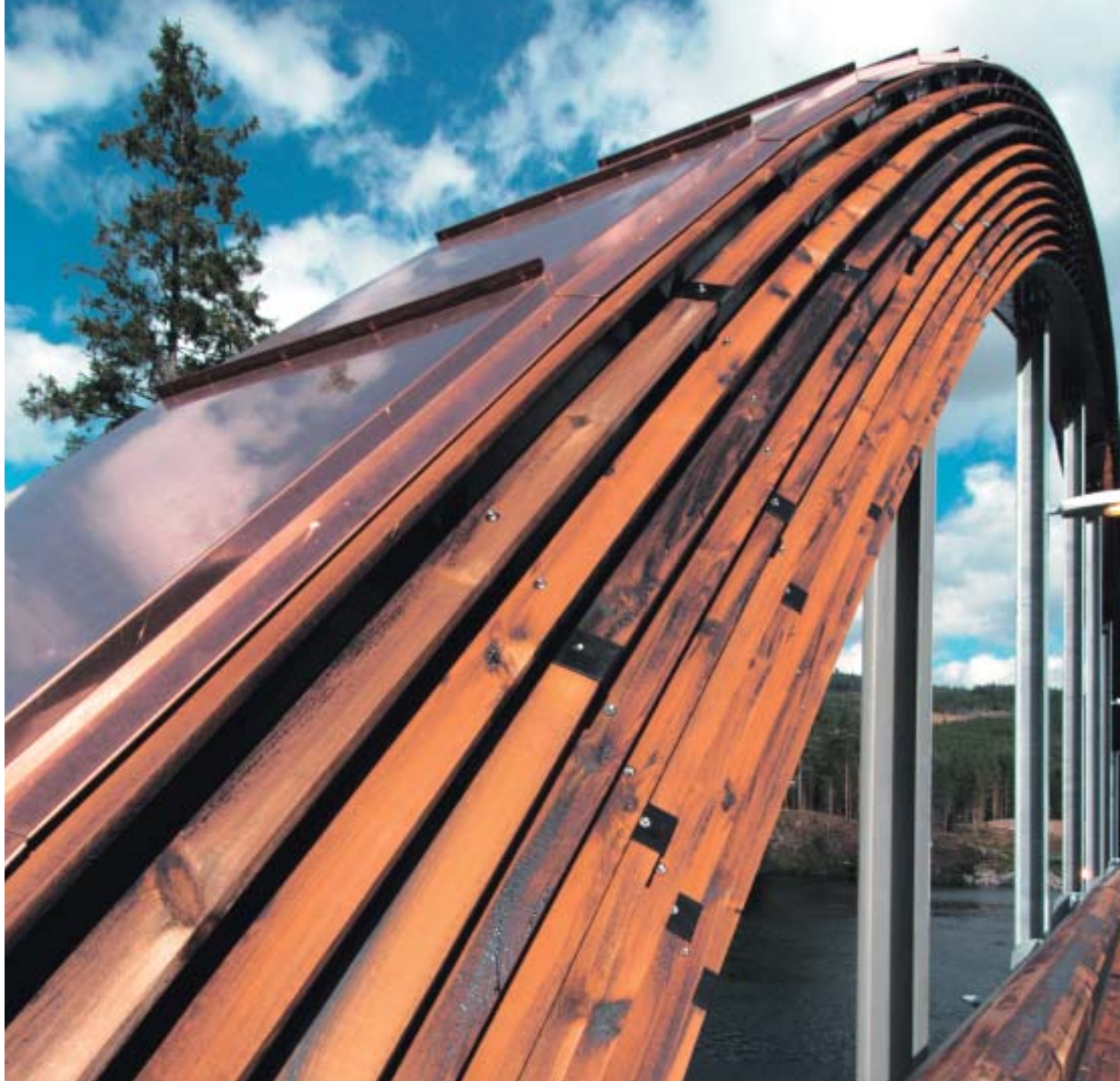
Nybergsund bru med limtrekonstruksjoner fra Moelven Limtre AS.
