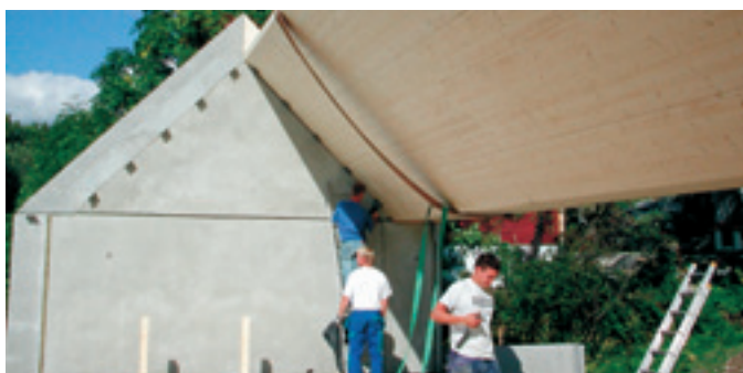
Montering av store limtrekonstruksjoner krever stor presisjon og nøyaktighet.
