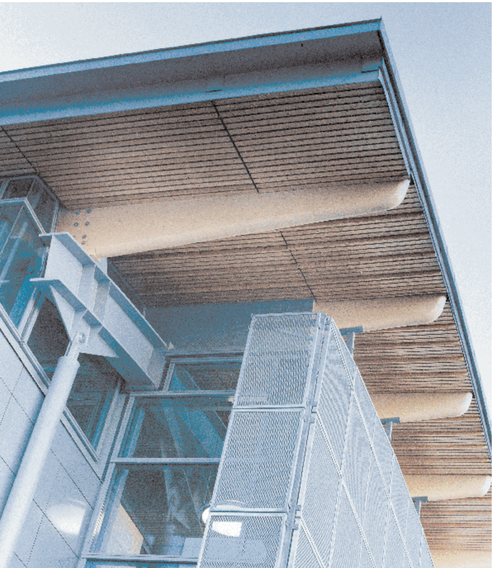
Limtre og TMF-impregnert (tungmetallfri) utvendig furupanel – Oslo lufthavn Gardermoen.
