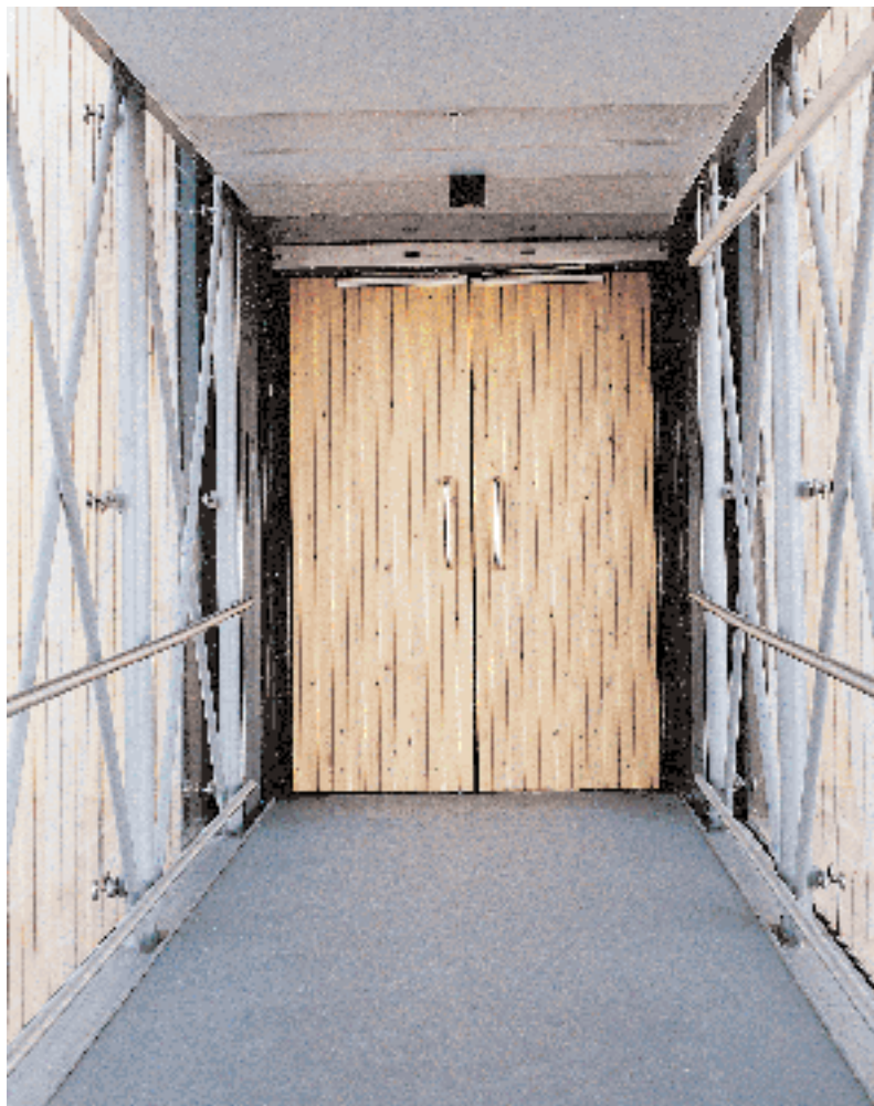
TMF-impregnert (tungmetallfri) furupanel – Oslo lufthavn Gardermoen.
