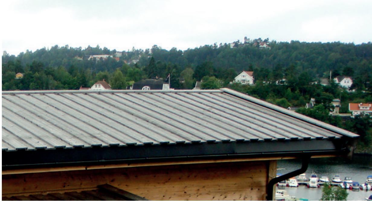
Tretak, termofuru, 20x140 mm.
