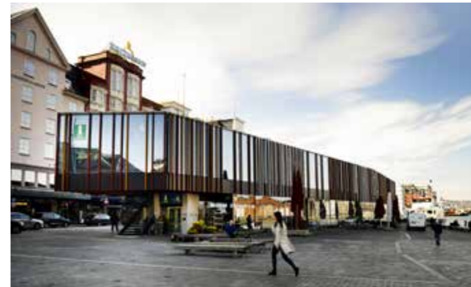
Mathallen Bergen. Spiler Furu Brannimpregnert.
