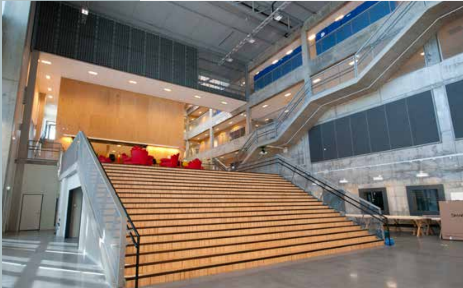
Færder VGS Tønsberg | White Arkitekt Brannimpregnert kryssfiner i kvistfri furu, B-s1,d0 med lett hvite pigmenter. Kilde: bygg.no / Trond Joelson
