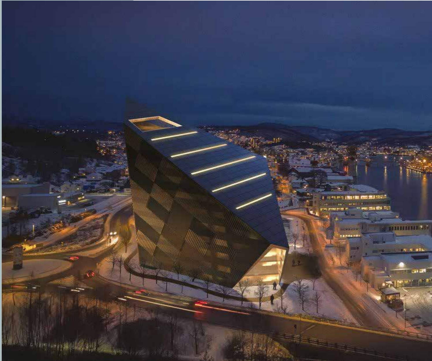
Powerhouse Telemark/ Porsgrunn | Snøhetta Arkitekter Brannimpregnert termofuru i B-s2,d0 Foto: R8 Property/ Snøhetta
