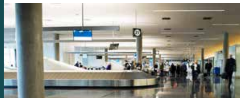
Oslo Lufthavn. Himlingsspiler i brannimpregnert gran B-s1,d0
