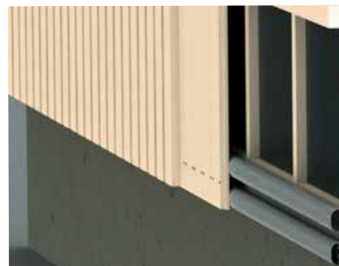
Bildet viser monteringen i den nederste delen bak fasaden.
