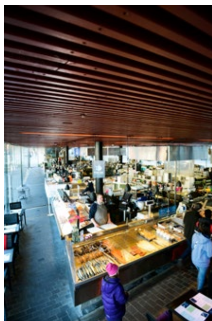
Mathallen Bergen | Arkitekt Christine Biesel Brannimpregnerte spiler i furu.
