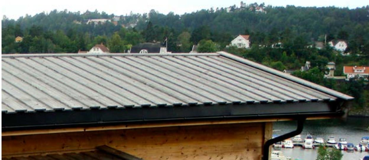
Tretak, termofuru, 20x140 mm.
